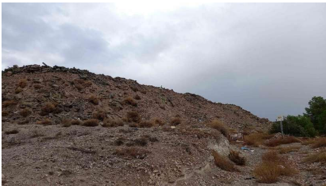
Imatge 21. Fotografia general on s'aprecia la magnitud de l'abocador.
